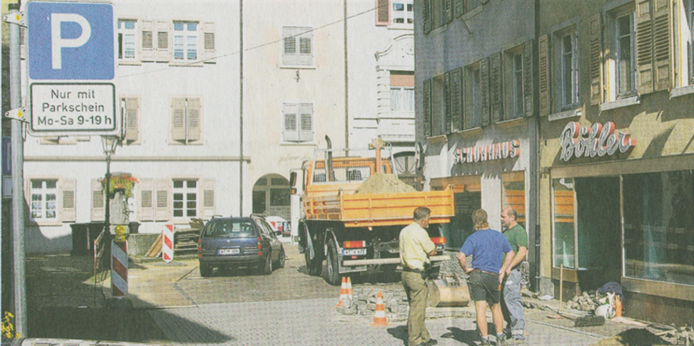
Abriß-Baustelle ist seit gestern das Schuhhaus Böhler in der Rheinstraße. Auch während der Bauarbeiten soll der Verkehr – wenn auch langsamer – durch die Rheinstraße rollen.
