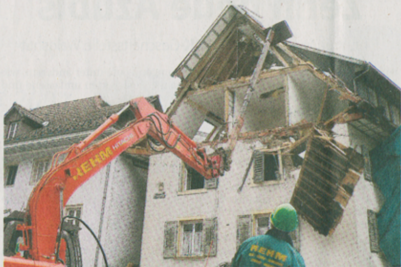
Das Böhler-Haus macht Platz für einen Neubau: Gestern begann die Lottstetter Firma Rehm mit dem Abriss des Hauses in der Rheinstraße. BILD: HERBST
